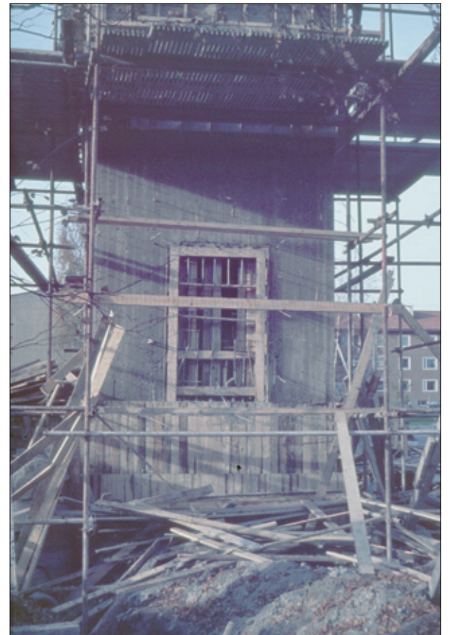
Keskeneräinen tapuli rakennustelineiden ympäröimänä.
