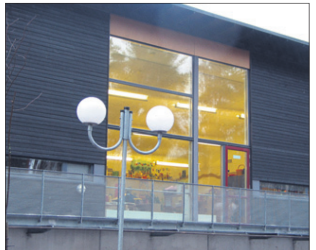
Nämä pihavalaisimet päiväkotihavallaisimet Haagassa ja iso ikkuna ovat olleet toistuvasti ilkivallantekijöiden vihan kohteena Isonnevanttiellä. Kuva KK.
