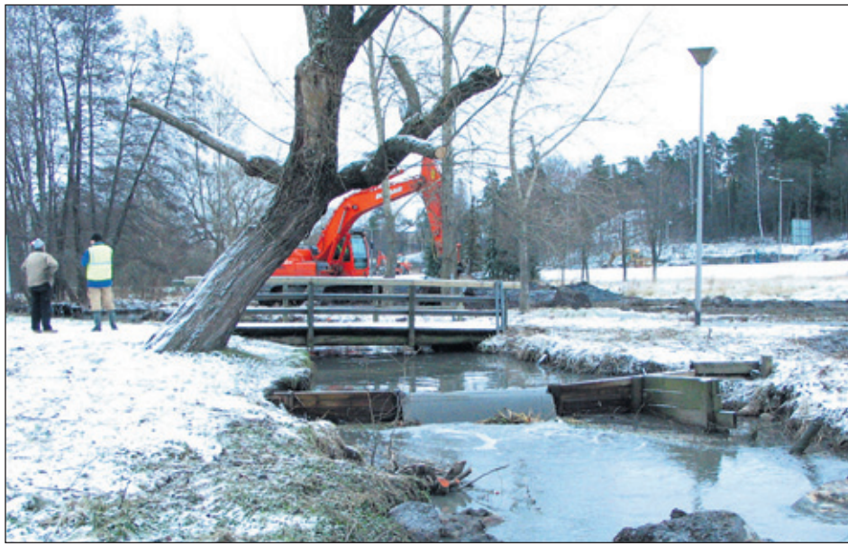
Mätäpuron kunnostetaan parasta aikaa Uudenmaan ympäristökeskuksen toimesta Kauppalanpuiston kohdalla. Kuva KK.
