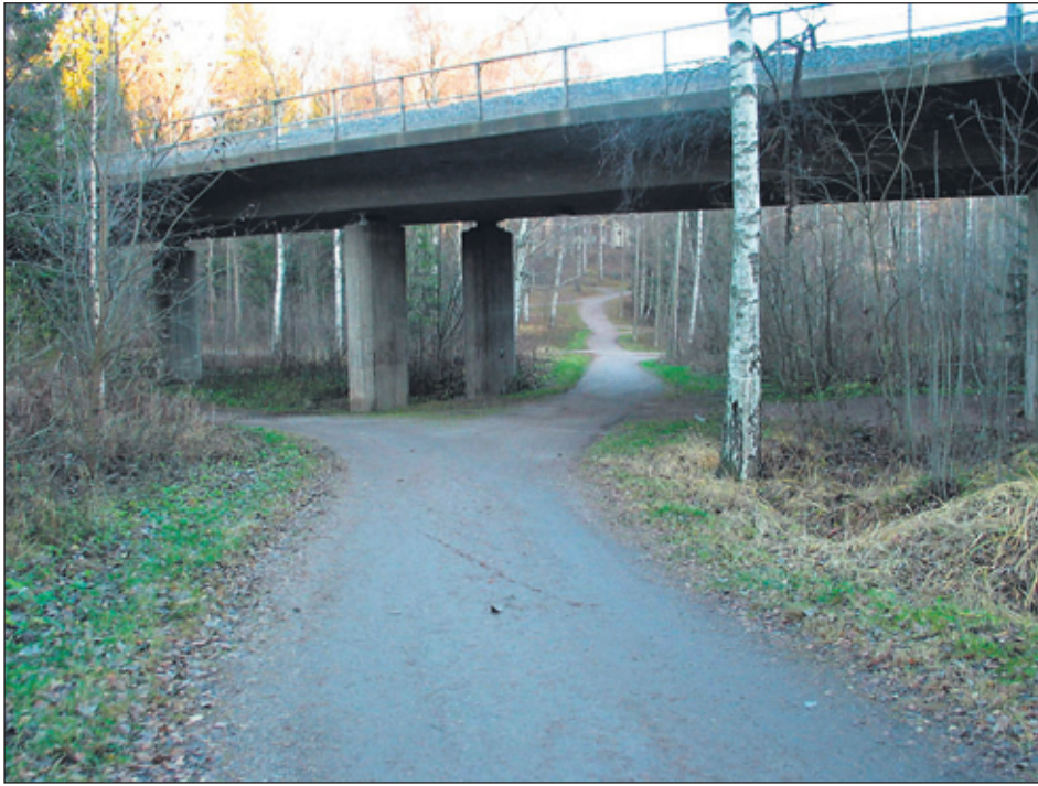
Tämä Lassilassa radan alikulkeva kävelytie on alunperin linnoituslinjan tarpeisiin tehty "tykkitie". Kuva KK.
